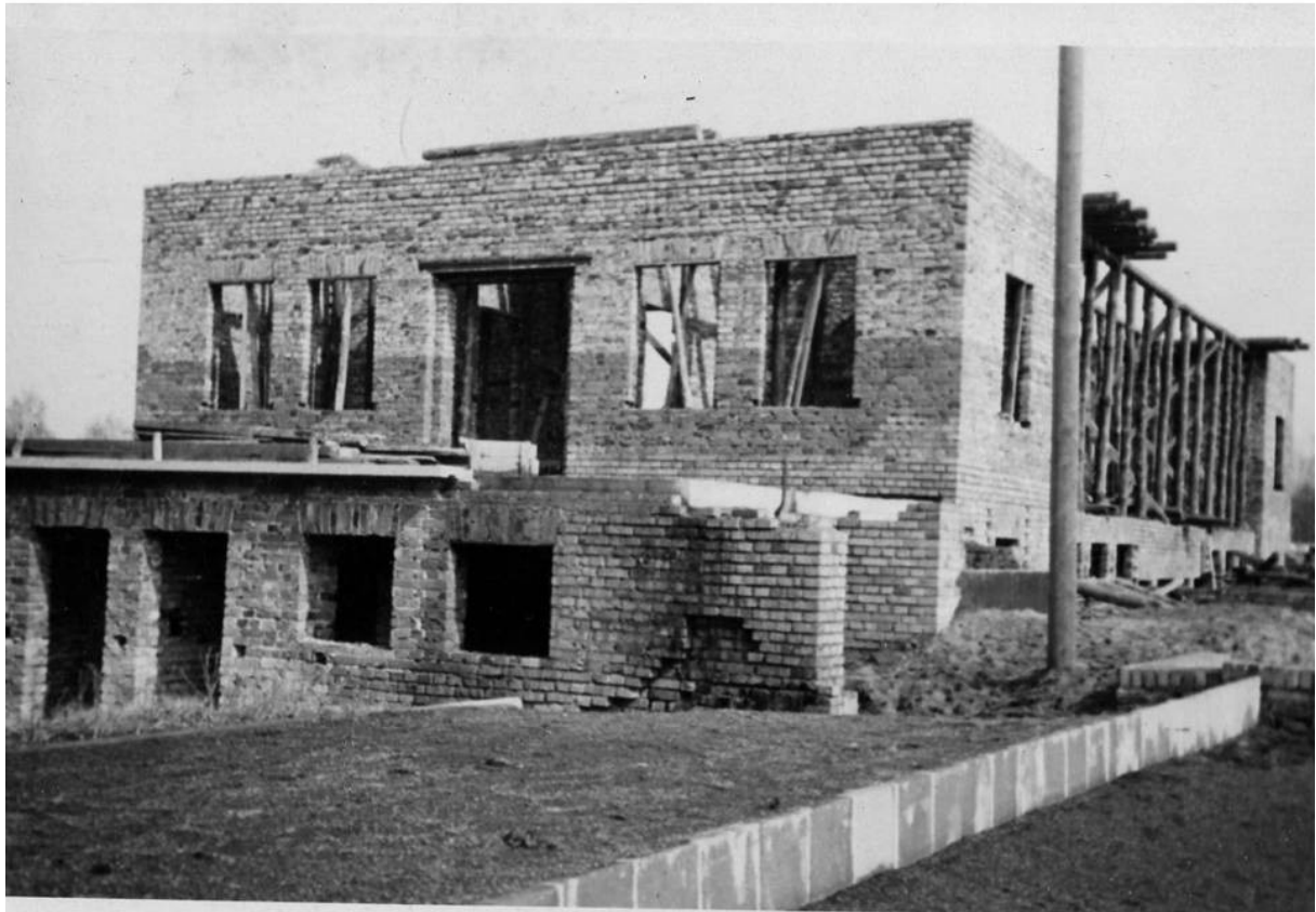
Rohbau des Sportlerheims Laubusch
